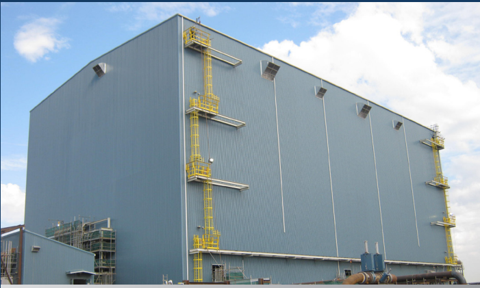
COMPLEXE DE TRAITEMENT DES RÉSIDUS COMPOSITES (CT) - SYNCRUDE
